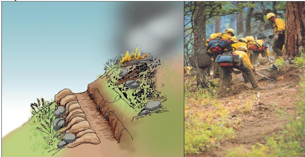
**Задняя траншея, построенная на склоне ниже линии огня**
