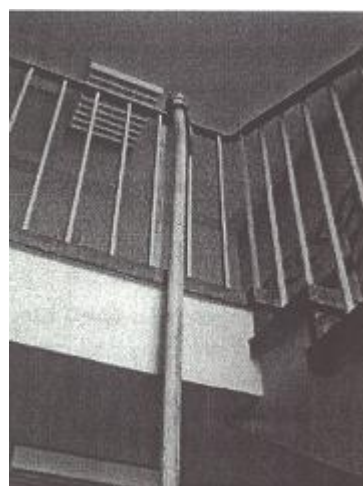
Рис.: прокладка рукава в лестничном марше
