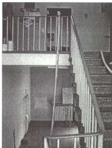
Рис.: прокладка рукава в лестничном марше
